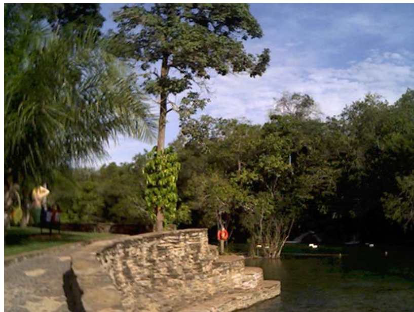
Figura 7. Estruturas de alvenaria construídas na área de preservação permanente (muro de arrimo) do rio Formoso.
