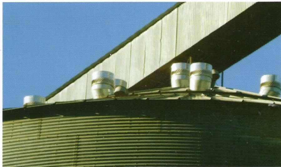
Figura 2. Silos com e sem o sistema de exaustão natural Cycloar , da Unidade Armazenadora da Soagro, município de Rio Verde-GO (Arquivo pessoal, 2012).
